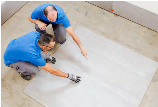
Choose the layout of the tiles | Selecciona la disposición de las piezas | Sélectionner la disposition des pièces | Wählen Sie die Anordnung der Fliesen
